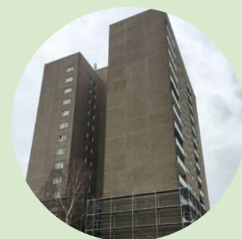
2015 startet die energetische Modernisierung.
