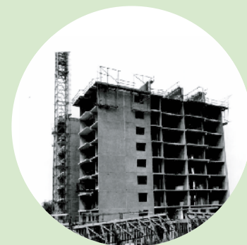
Bau des Hochhauses 1972.
